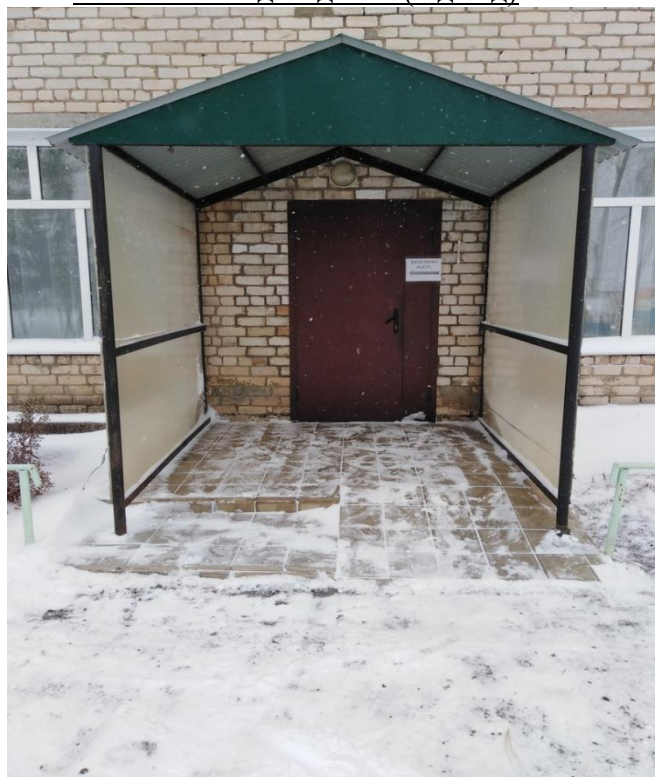
Фото №4 Вход в здание (в д/сад)
