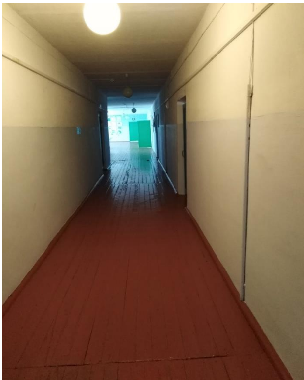
Коридор 2-го этажа
